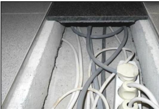
Le sol technique est constitué d'une combinaison entre le double sol continu **DRAINAIR-sape** et des gaines bien situées pour les raccordements, boîtes de dérivation et prises de courant, ... Découper les canaux dans la couche de compression finie et prévoir un couvercle de recouvrement.
