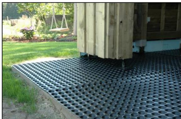
**DRAIN<sup>AIR</sup>-sape** pour éviter des interactions nuisibles entre revêtement et support.
