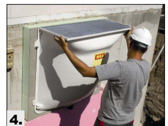
4. MEA Lichtschachtmontage mit dem entsprechenden Befestigungs-Set zur Verhinderung von Wärmebrücken.
