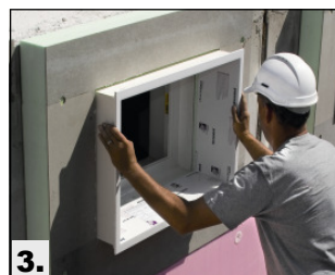
3. Perimeter-Abdeckrahmen montieren: Kleber aufbringen und Abdeckrahmen in die Zargenöffnung einschieben.
